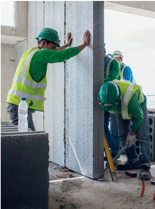
Установка панелей Acotec
