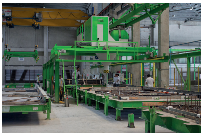
Бетонукладчик Comcaster на производстве DDT
