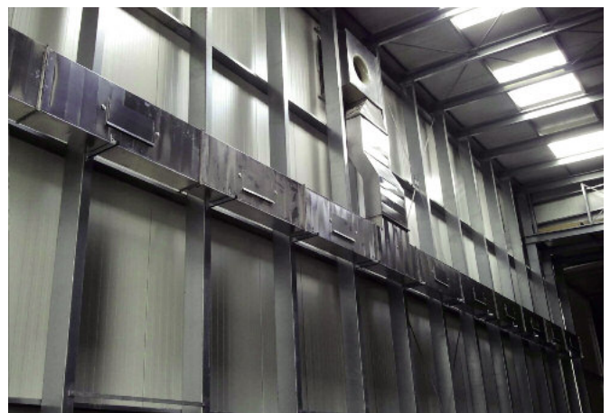
Długi okres użytkowania systemu, jego niezawodność i niezmiennie wysoką w czasie wydajność zapewnia konstrukcja ze stali szlachetnej z izolowaną obudową.
