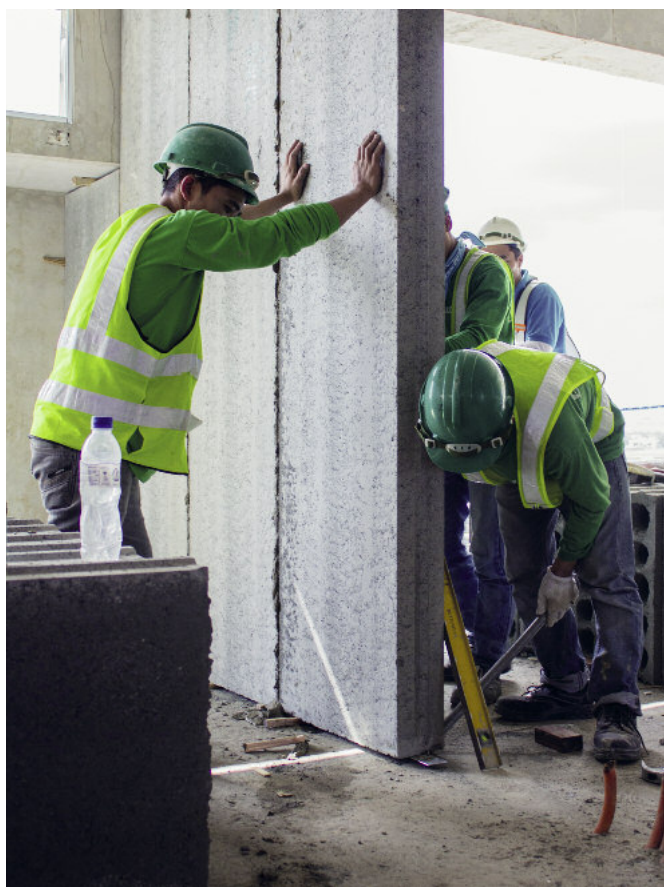
Montaż ściany Acotec.
