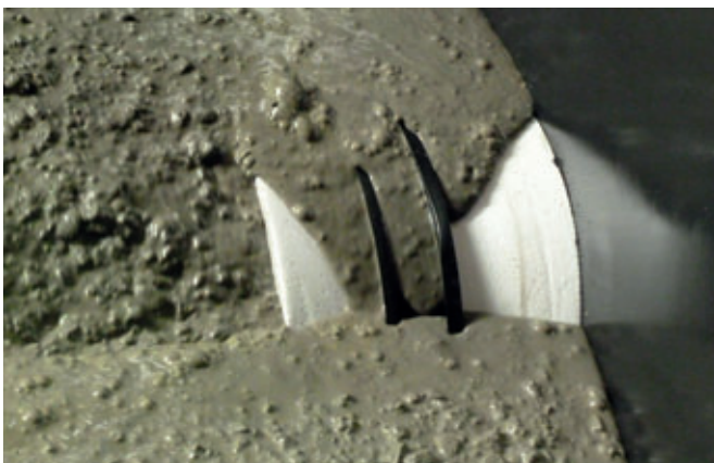
Collegamenti delle tubazioni a tenuta grazie alle guarnizioni "integrate" ancorate nel calcestruzzo
