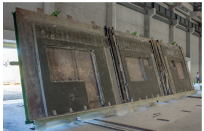
Facciate prefabbricate alla stazione di ribaltamento
