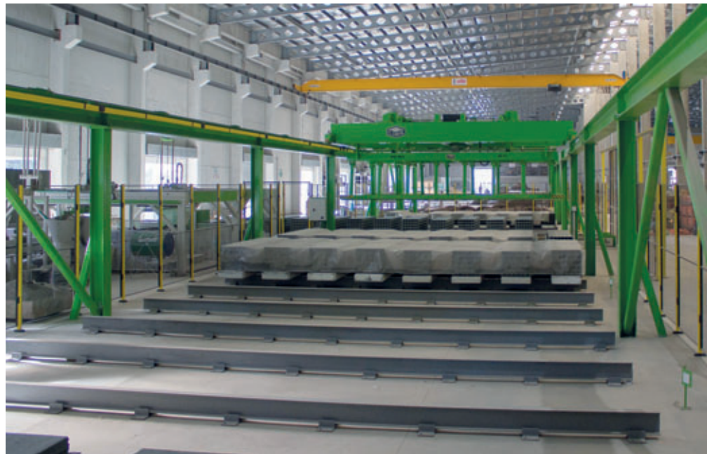
Acotec-Produktionslinie mit automatischem Voraushärtungslager bei DDT
