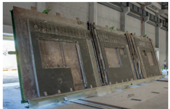
Fertigteilfassaden auf der Kippstation
