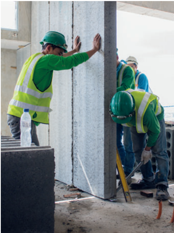
Montage einer Acotec-Wand
