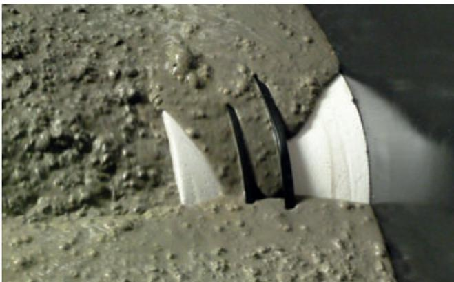
Dichte Rohranschlüsse dank fest im Beton verankerter „integrierter“ Dichtungen
