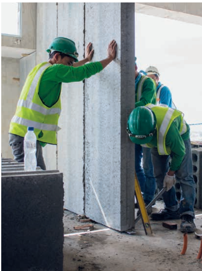
Acotec 墙体安装
