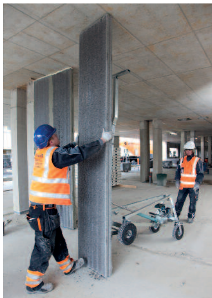
Монтаж стеновой панели Acotec: Команда из двух человек монтирует в день 40 - 60 м 2 панелей Acotec
