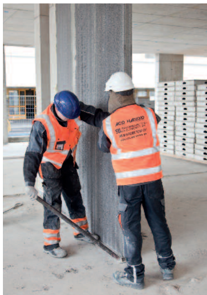
Монтаж стеновой панели Acotec: Команда из двух человек монтирует в день 40 - 60 м 2 панелей Acotec
