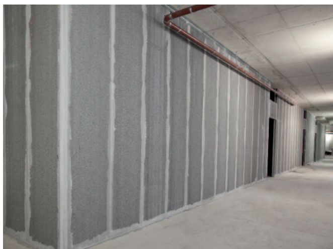
Длинная панель Acotec готова к отделке
