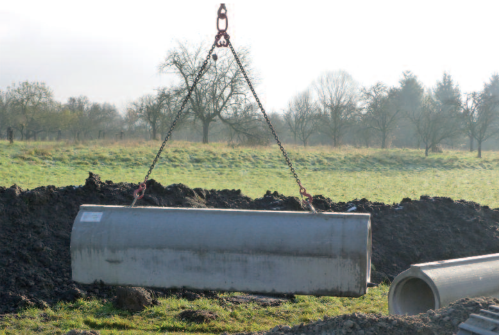
Простая и надежная погрузка / разгрузка труб Perfect Pipe на стройплощадке благодаря замоченным анкерам с круглой головкой
