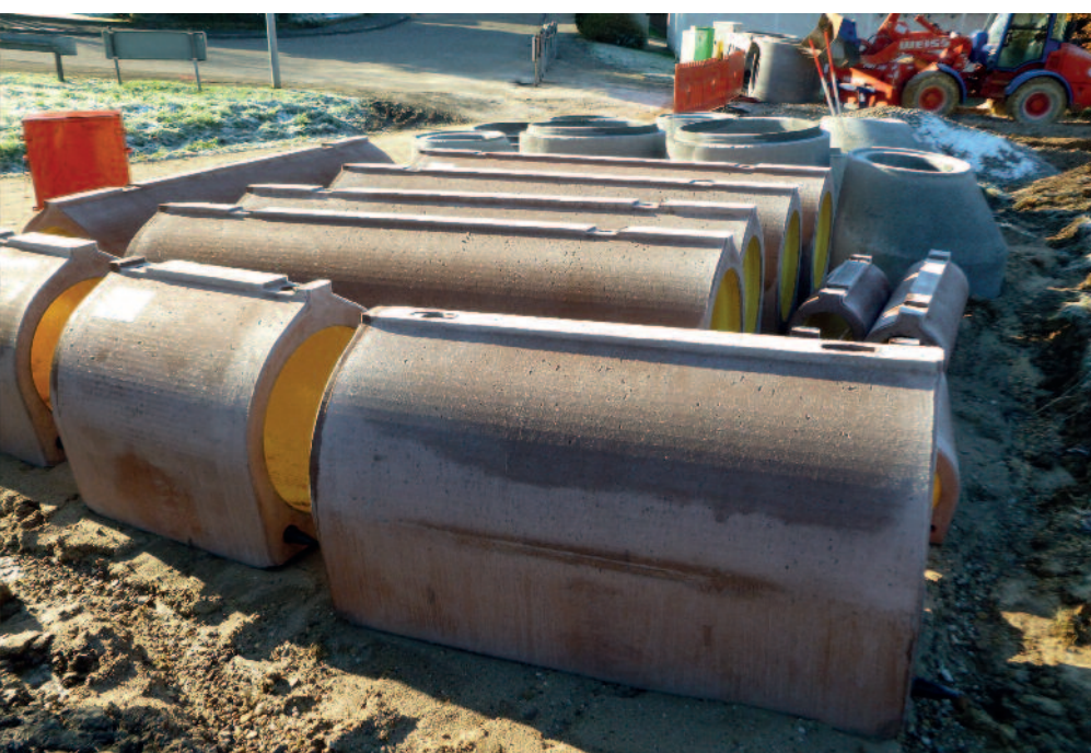
Трубы Perfect Pipe с облицовкой HDPE перед укладкой в стандартную монтажную длину (3 м), в виде фасонной трубы индивидуальной длины и в виде шарнира 1 м
