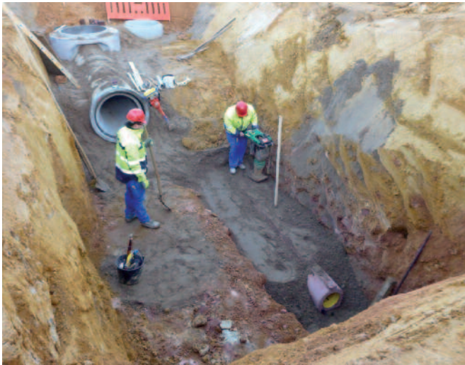
Быстрые темпы укладки за счет простого и практичного уплотнения зоны трубопровода
