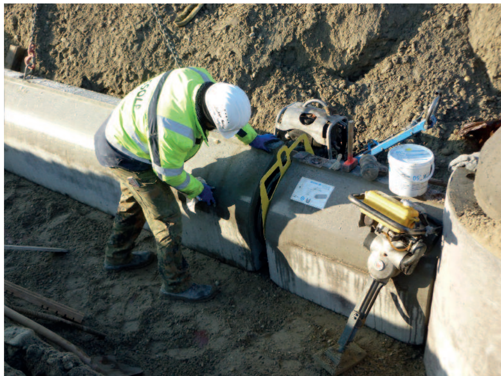
Соединение шарнирных элементов с дном колодца осуществляется при помощи тех же коннекторов, что и для межзвеньевых креплений
