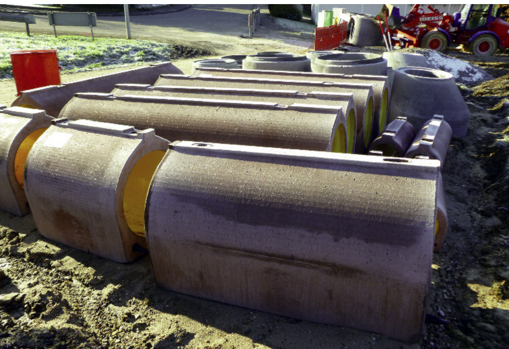
Rury Perfect Pipe z wewnętrzną wykładziną PE-HD w standardowej długości (3 m), odcinki łączące o długości standardowej (1 m) i o różnych długościach wg projektu tuż przed montażem.
