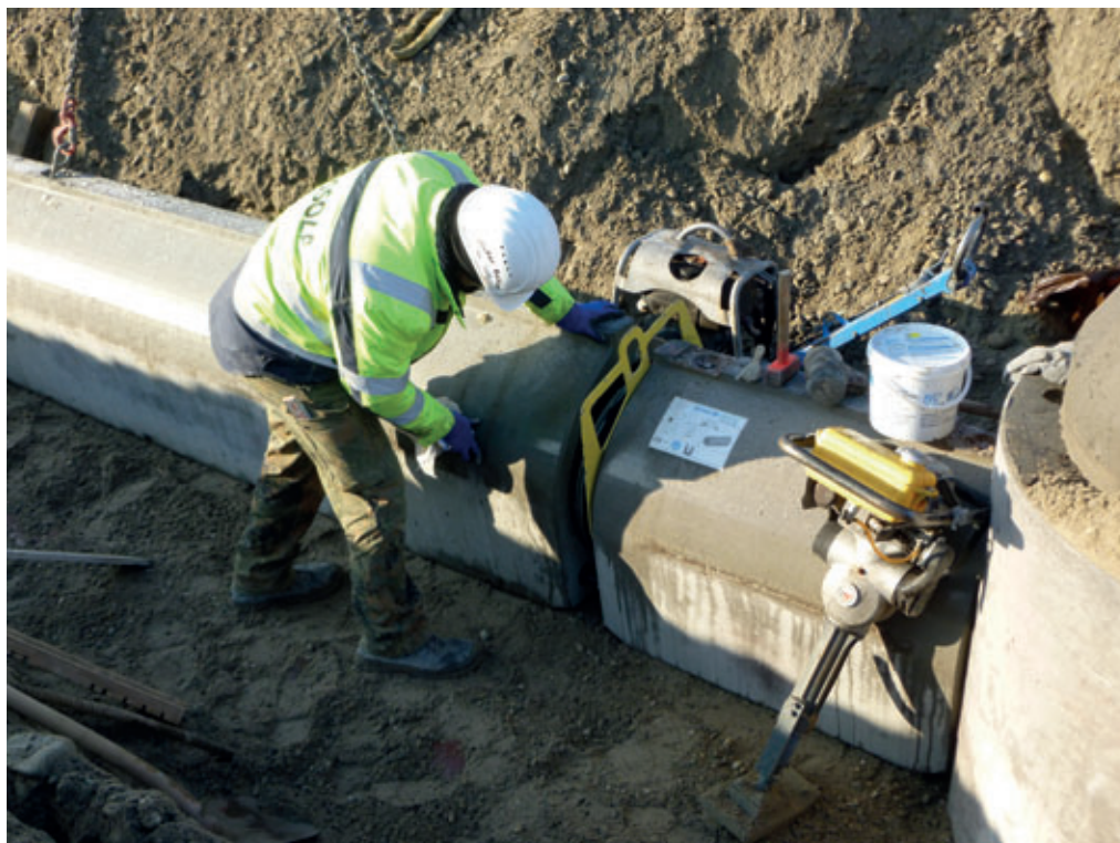
Il collegamento dei pezzi articolati alle parti inferiori del pozzetto viene eseguito con gli stessi connector impiegati nel collegamento da tubo a tubo
