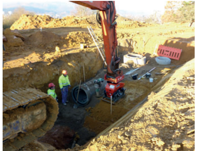
Montaggio rapido grazie alla compattazione semplice e funzionale della zona di conduzione
