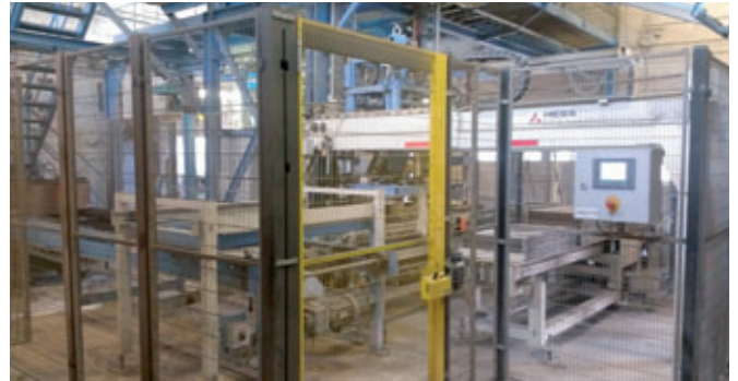
Integrazione di un accumulo per lamiera nell'impianto presente
