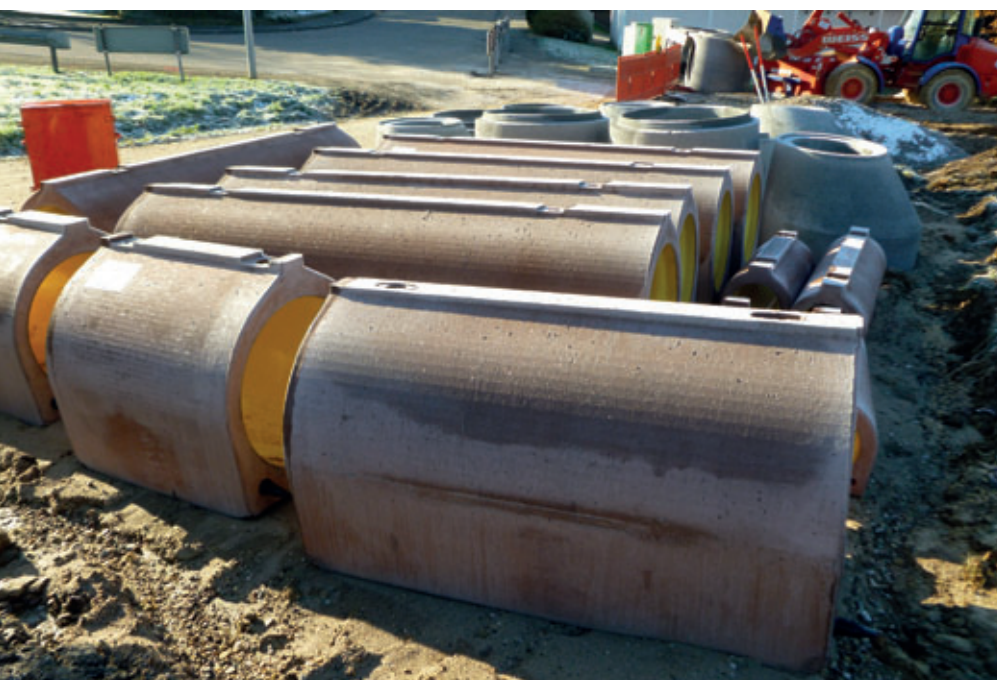
Tuyaux Perfect Pipe avec liner PEHD avant la pose : en longueur standard (3 m), en longueur sur mesure pour les tuyaux d'ajustement et en longueur 1 m pour les tuyaux de raccordement.
