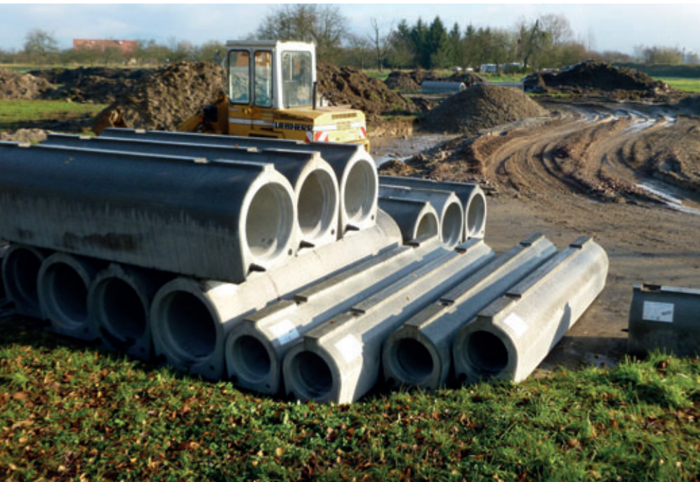
Les tuyaux béton peuvent être fabriqués avec lit de pose, selon le même procédé de fabrication que pour les tuyaux composites, plastique et béton.
