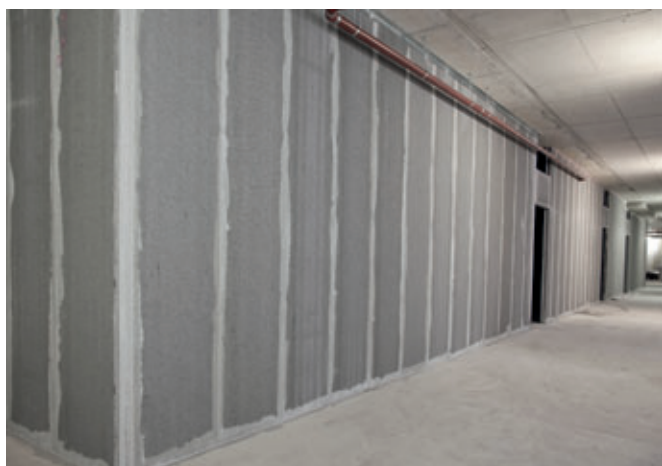
Long mur Acotec droit avant sa finition.
