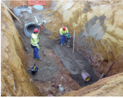
Avance rápido del montaje mediante compactación sencilla y práctica del área de tuberías
