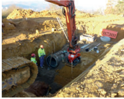
Avance rápido del montaje mediante compactación sencilla y práctica del área de tuberías
