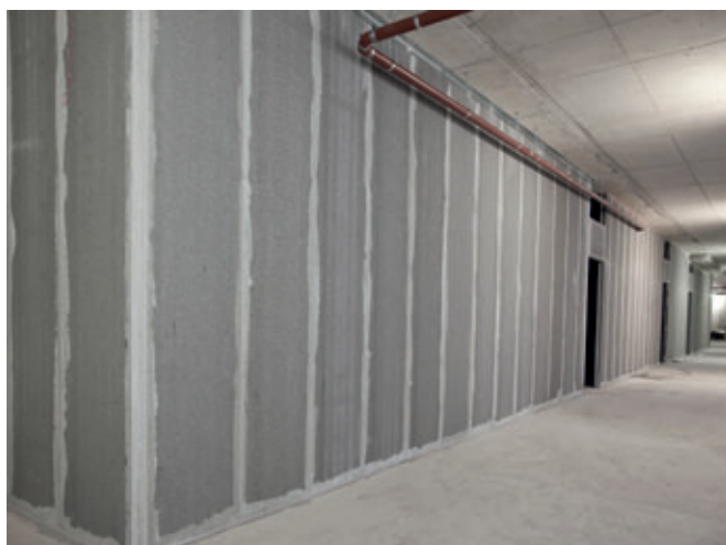
Lange, gerade Acotec-Wand vor der Endbearbeitung.
