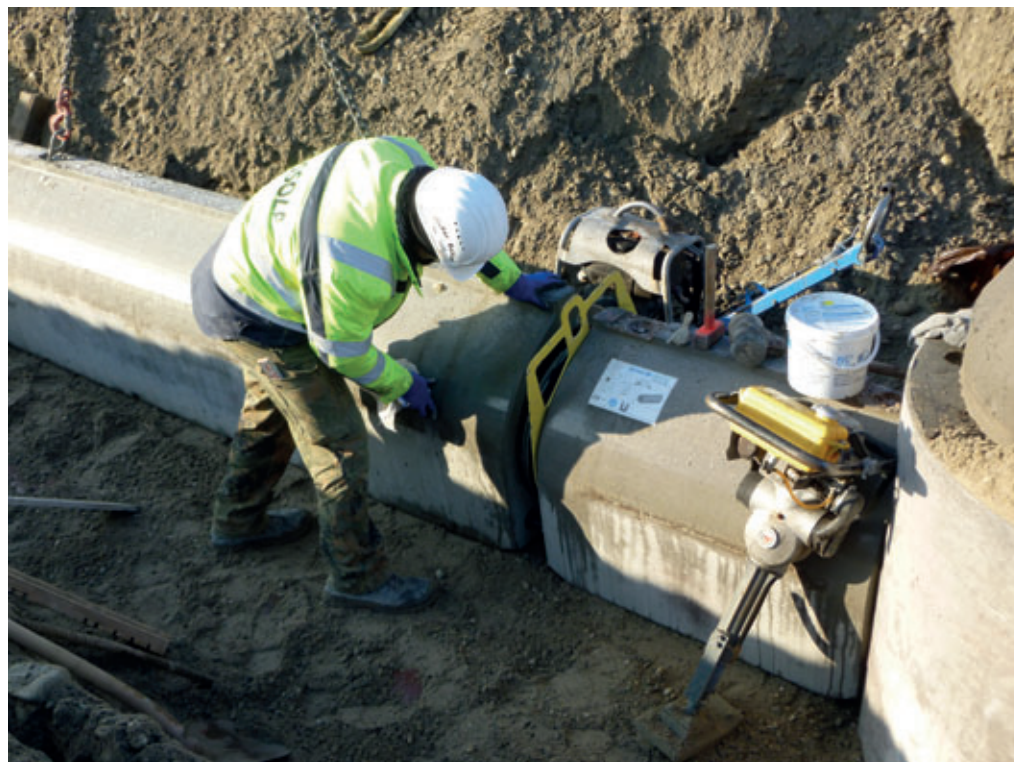
Die Anbindung von Gelenkstücken an Schachtunterteile erfolgt mit den gleichen Connectoren wie die Verbindung Rohr-Rohr
