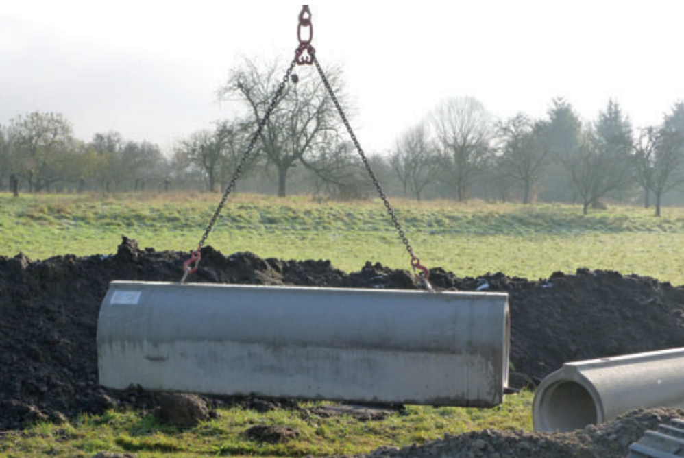
Einfaches und sicheres Handling der Perfect Pipe Rohre auf der Baustelle mit eingegossenen Kugelkopfkankern
