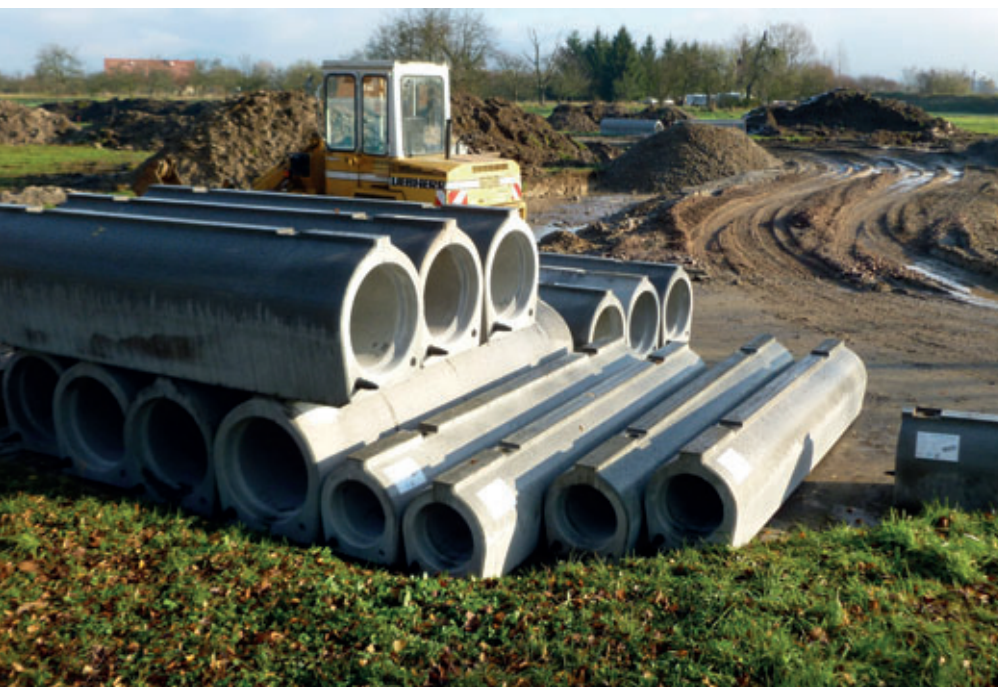
Betonrohre können mit der gleichen Fertigungstechnik in Fußrohr-Geometrie produziert werden wie Beton-Kunststoff-Verbundrohre
