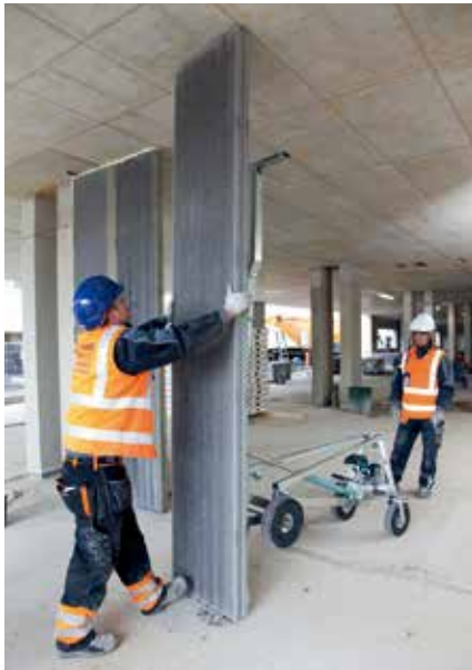
安装 Acotec 墙板 2 人一组一个工作日便可安装 40-60 m 2 的 Acotec 墙板
