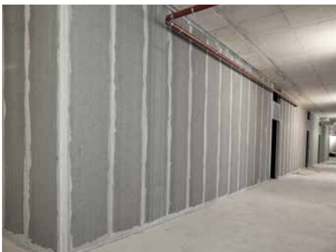
高大的 Acotec 墙板竖立排放，以便进行下一步的涂饰操作
