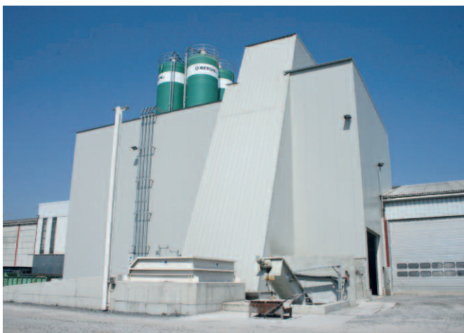
Фирма Ubo engineering b.v. сконструировала новый центральный узел БСУ
