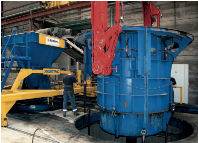
После распалубки форма возвращается на рабочую станцию для изготовления следующего изделия
