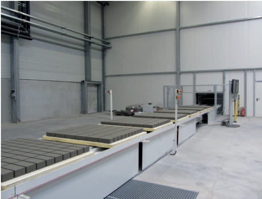
Транспортировочная установка на мокрой стороне
