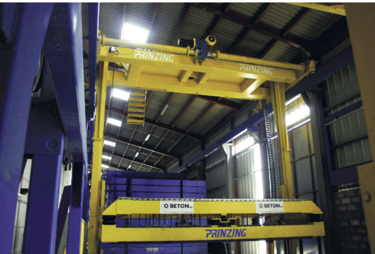
Robot suwnicowy w sposób całkowicie zautomatyzowany obsługuje magazyn form maszyny Zelus.
