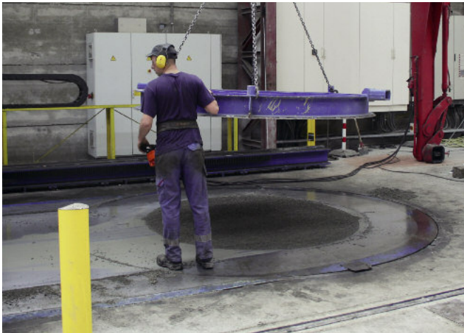
Po napełnieniu mieszanką betonową i jej zagęszczeniu na formę automatycznie nakładany jest podkład produkcyjny.
