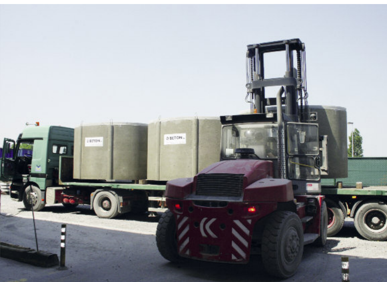
Gotowe zbiorniki betonowe są ładowane na ciężarówkę w celu przetransportowania na plac budowy.
