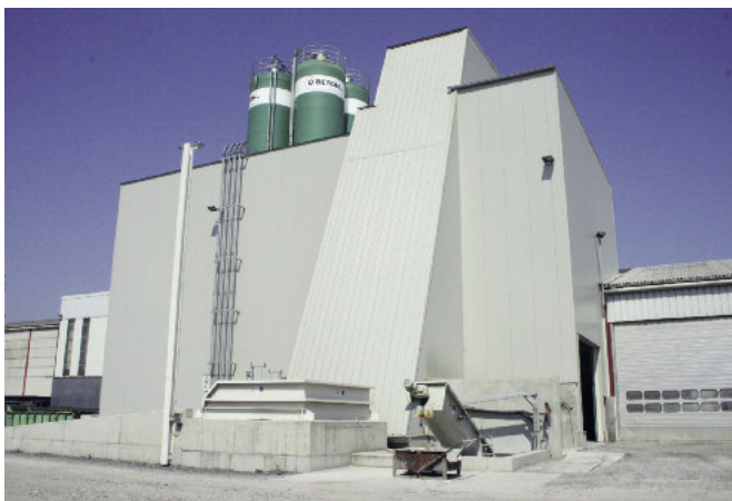
Firma Ubo engineering b.v. wykonała całkowicie zabudowany węzeł betoniarski przylegający bezpośrednio do hal produkcyjnych.
