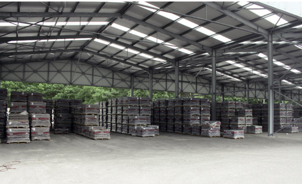
Typowa sytuacja w zakładzie firmy Ebema: nowe elementy betonowe przechowywane na zadaszonym placu składowym.
