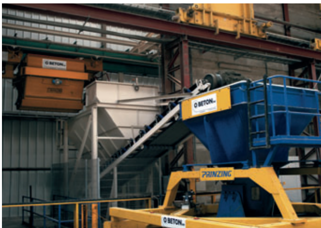
Tramite un trasportatore a vagonetti e un pre-silo si alimenta Atlas con il calcestruzzo a consistenza di terra umida
