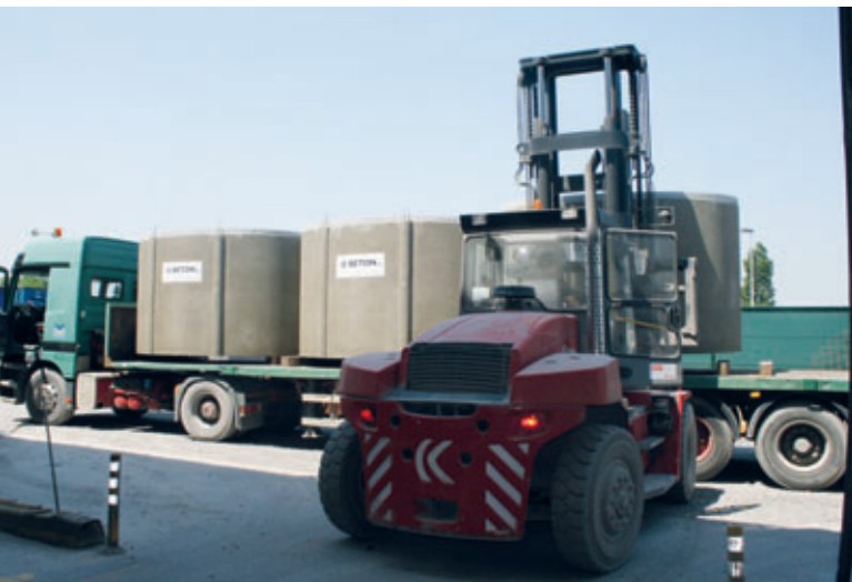
I serbatoi in calcestruzzo, finiti, sono caricati sul camion per il trasporto al cantiere.
