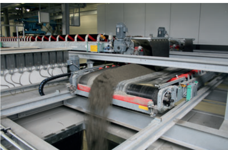
Les convoyeurs à courroie de VHV Anlagenbau transportent le béton entre les malaxeurs et la machine de production de blocs
