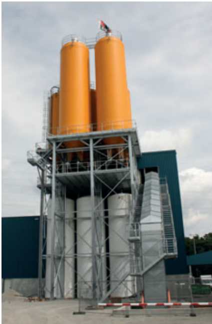
Tour de malaxage du nouveau hall de production
