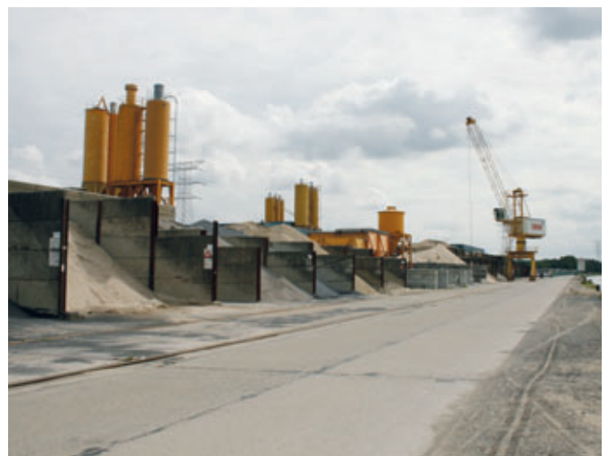
Chez Ebema, 90 % des granulats sont livrés par voie d'eau navigable
