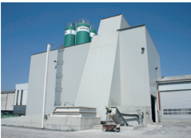
Ubo engineering b.v. fabriqua la nouvelle centrale de malaxage, entièrement fermée et intégrée aux halls de production.
