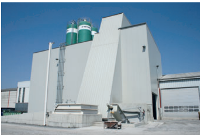
Ubo engineering b.v. construyó la nueva central de mezclado en un recinto completamente cerrado directamente contiguo a las naves de producción.
