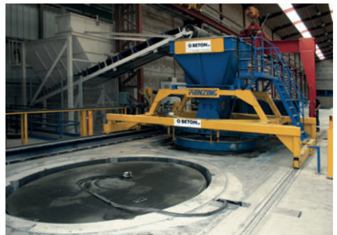
En la estación de fabricación 1 se produce, el silo de hormigón se llena en la posición central y la estación de fabricación 2 se prepara para el siguiente producto.
