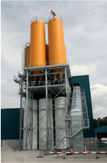
Torre de mezcla de la nueva nave de producción
