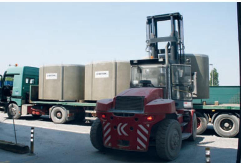
Die fertigen Betonbehälter werden für den Transport zur Baustelle auf den LKW verladen.
