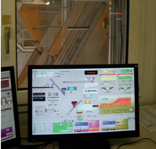
Gesteuert werden alle Misch- und Dosiervorgänge mit der Steuerung von Sauter.
