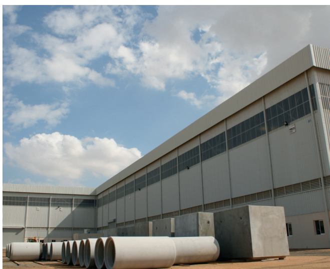
Компания Amiantit Oman была основана в 1974 г. и специализируется в строительной области. Штат сотрудников насчитывает более 900 человек, при этом 80 из них заняты на предприятии Amiantit Oman Concrete Products LLC.
