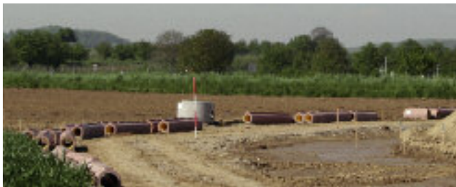
Rury oraz studnie gotowe do instalacji.
