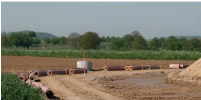
Tubi e pozzetti pronti per la posa
