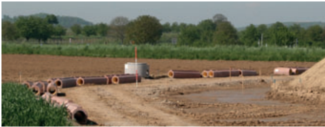
Tuyaux et regards sont prêts à être posés
