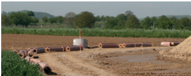
Material de tubos y pozos, listo para su instalación.
