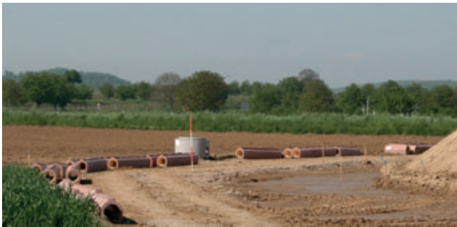
Rohr- und Schachtmaterial stehen bereit zum Einbau
