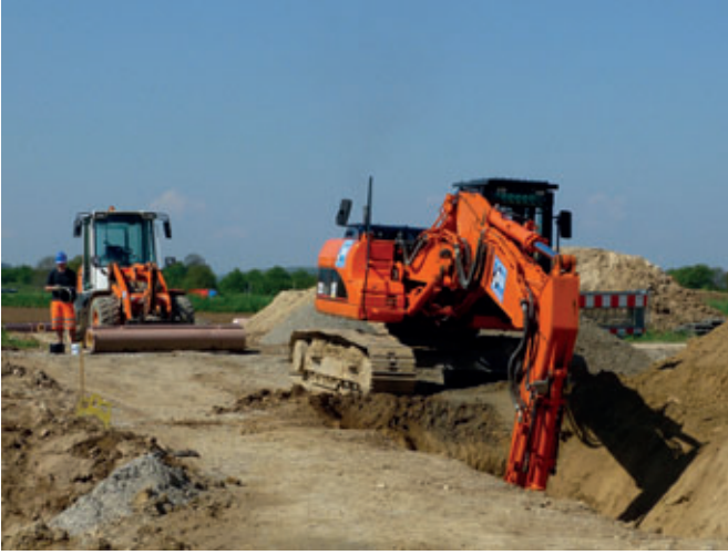
Der Einbaufortschritt begeistert die Verantwortlichen auf Auftraggeberseite ebenso wie jene im Ingenieurbüro und bei der Baufirma
