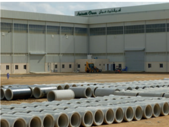
Das modernste Betonrohrwerk im Sultanat Oman wurde von Amiantit Oman Concrete Products LLC im Herbst 2012 eröffnet.
