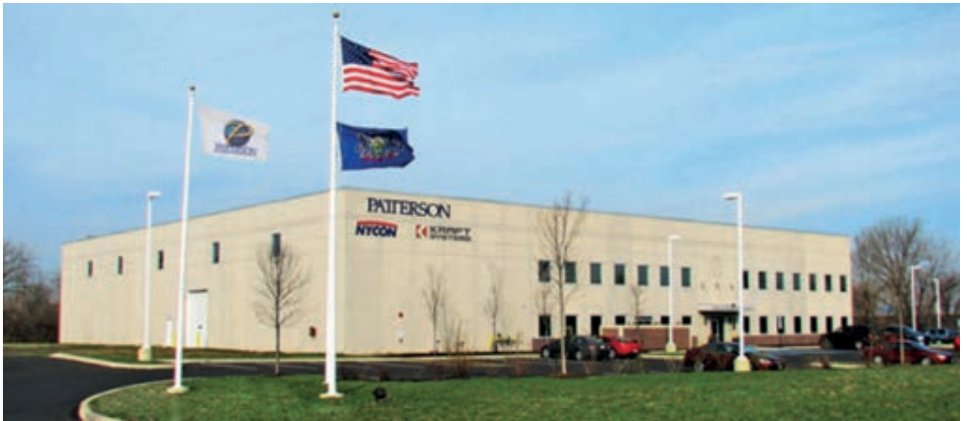
Kraft 养护系统公司位于宾夕法尼亚州 Fairless Hills 地区 A.L. Patterson, Inc. 工业园的北美总部
