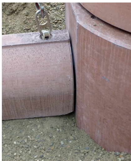
Геометрии патрубков колодца Perfect и труб Perfect Pipe согласованы
