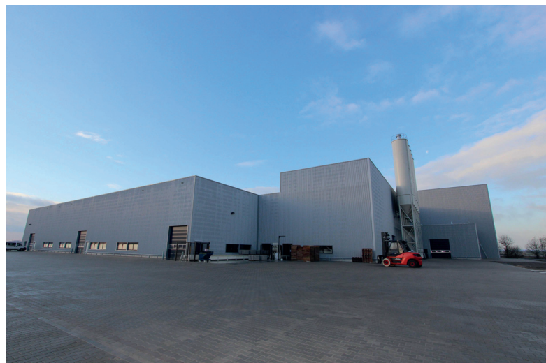
Третья линия на заводе Redsun в Кевелэре: вид сзади
