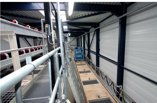
Новая производственная линия работает в общей сложности с семью бункерами (190 м 3 каждый) для основного бетона и двенадцатью бункерами (40 м 3 каждый) для лицевой смеси
