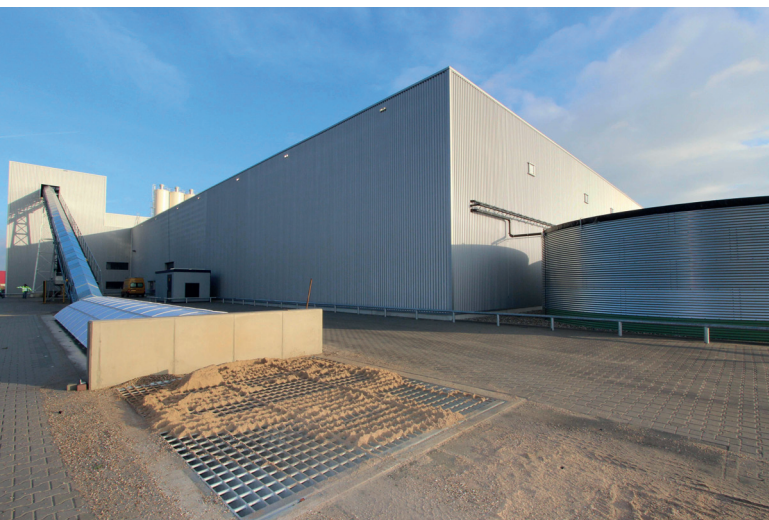
Сырье напрямую разгружается в приемный бункер и при помощи скипа подается на распределительный ленточный транспортер
