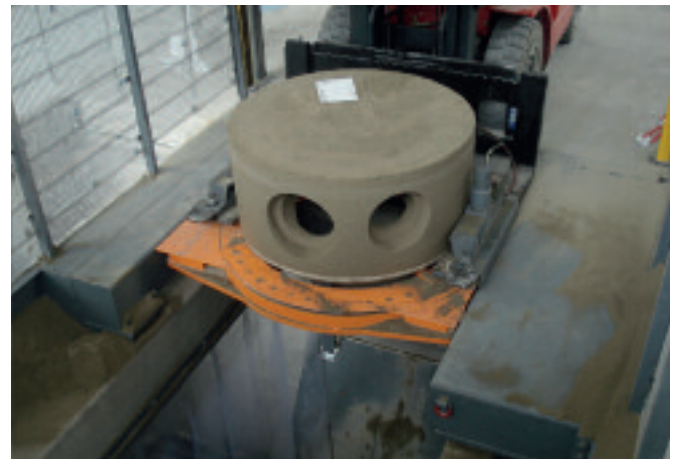
Po zakończeniu frezowania podstawa studzienki jest odtransportowywana ze stanowiska roboczego.
