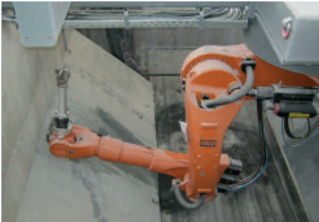
Robot frezujący pracuje pod posadzką.
