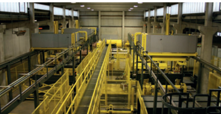
Realizzazione di un tubo Perfect Pipe presso lo stabilimento Müller di Breisach. La produzione avviene in modo quasi del tutto automatizzato in varie stazioni.
