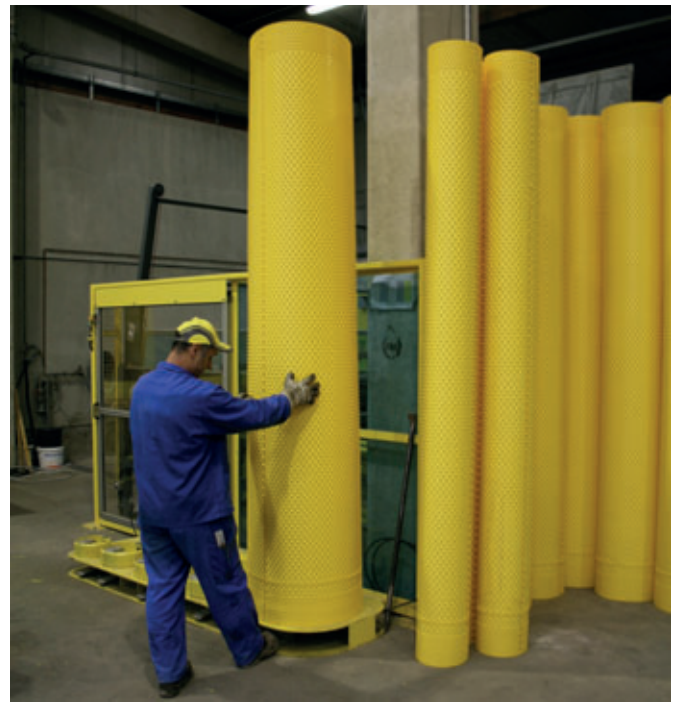
La resistenza alla trazione del cordone di saldatura può essere controllata subito dopo la conclusione della fase di saldatura.
