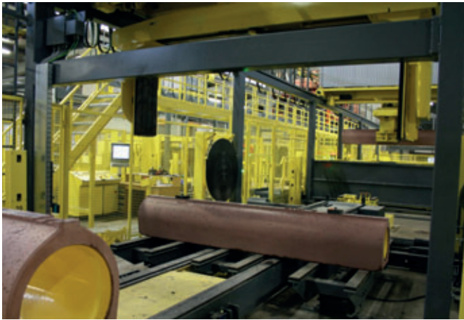
Prima di abbandonare la linea di sformatura tutti i tubi vengono sottoposti a un test di tenuta.
