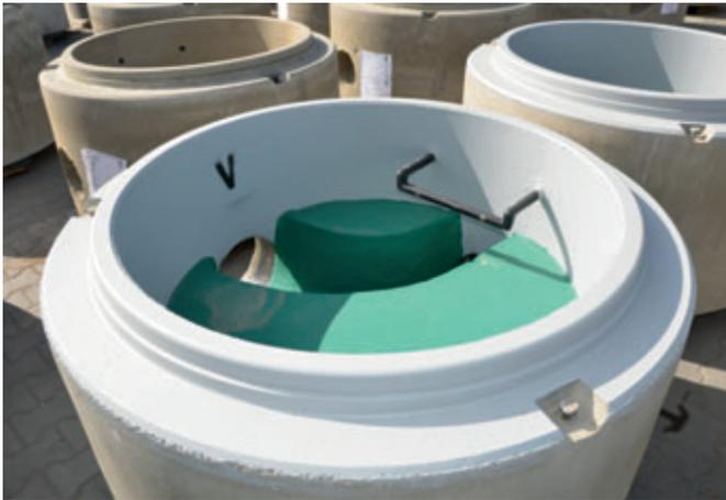
Les cunettes et les ouvertures de raccordement sont fraisées de façon entièrement automatique et les trous pour les étriers également réalisés
