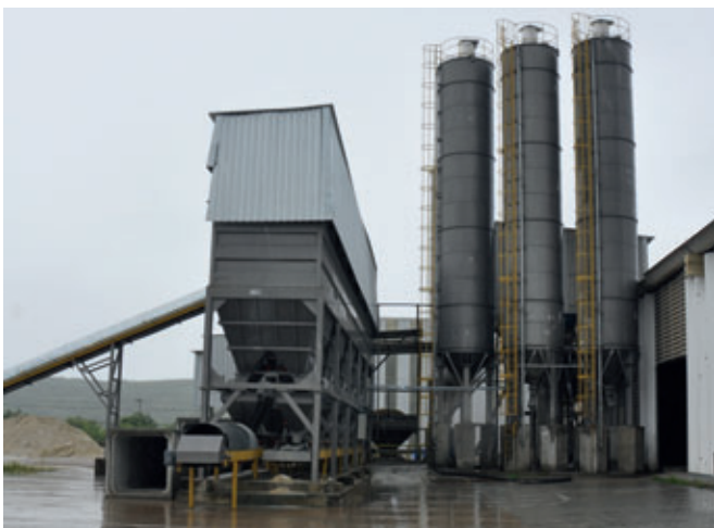
Installation de dosage et de mélange
