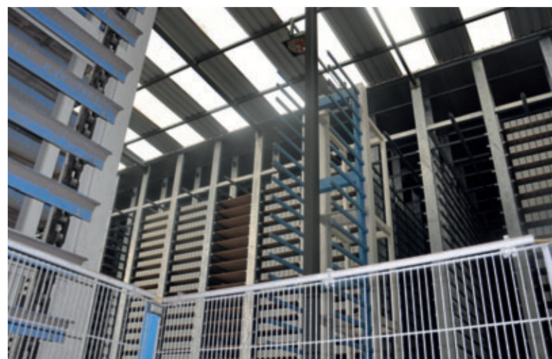
Instalación de estanterías
