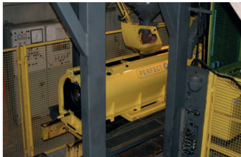
Während des Betonierens steht die Form auf einem verfahrbaren Tisch.
