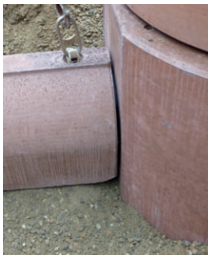
Die Anschlussgeometrie von Perfect-Schacht und Perfect Pipe wurden genau aufeinander abgestimmt.
