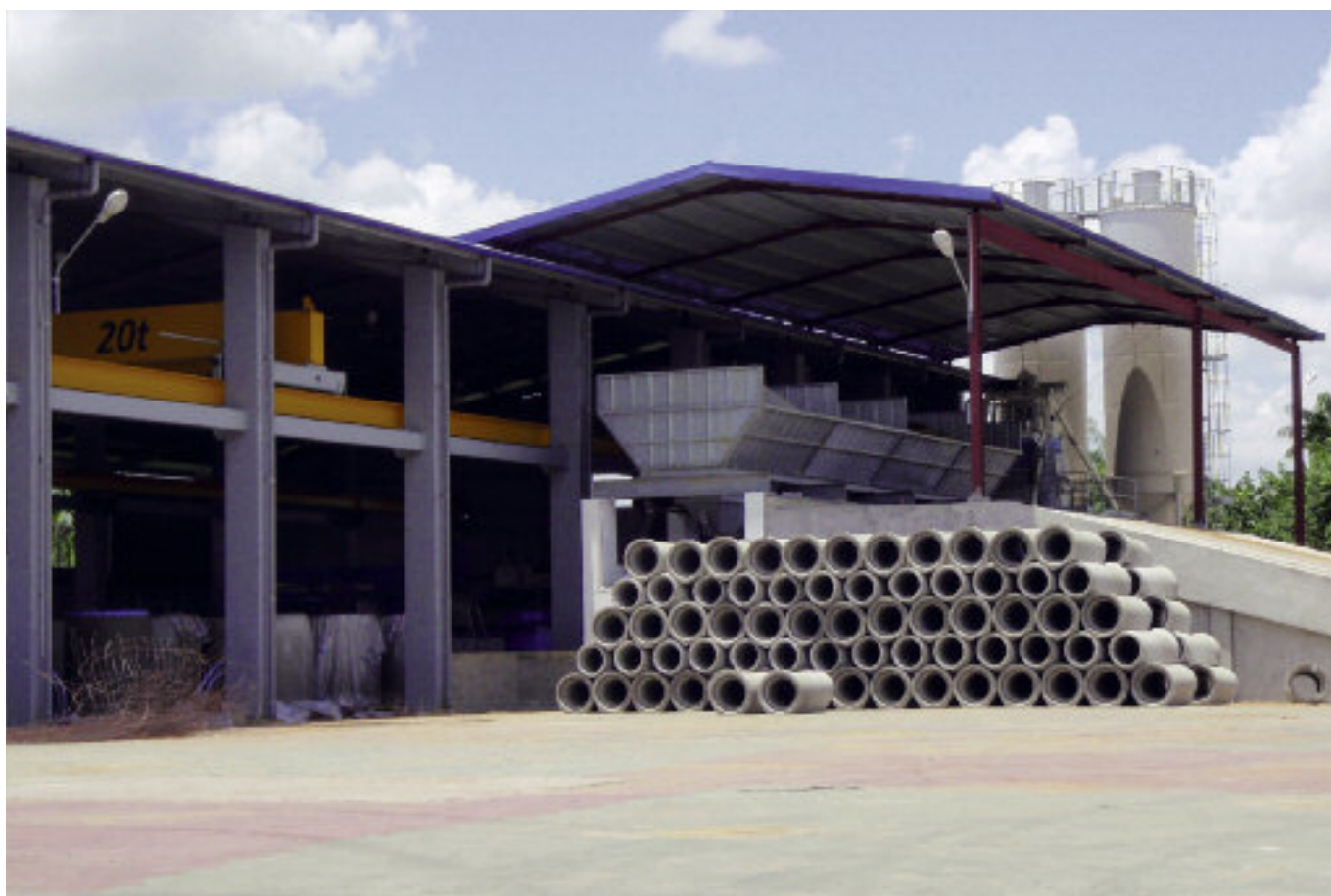
Nowy zakład produkcji rur, widok z zewnątrz.
