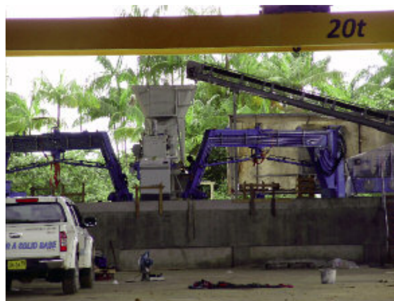
Montaż nowej linii technologicznej.
