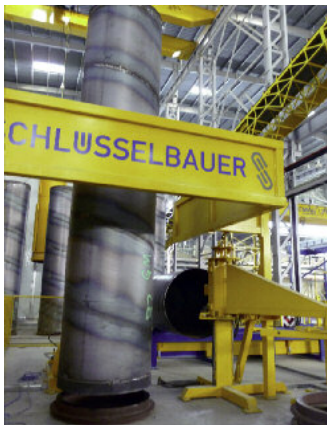
Stalowy cylinder zostaje umieszczony automatycznie na pierścieniu formującym i po uzbrojeniu formy zasypany betonem o niskiej wilgotności. Tak powstaje warstwa wewnętrzna rury.
