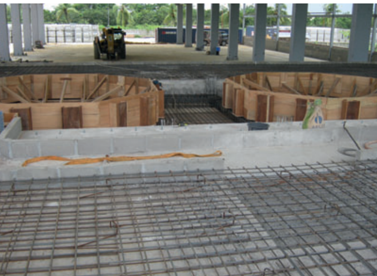
Preparación de las cimentaciones
