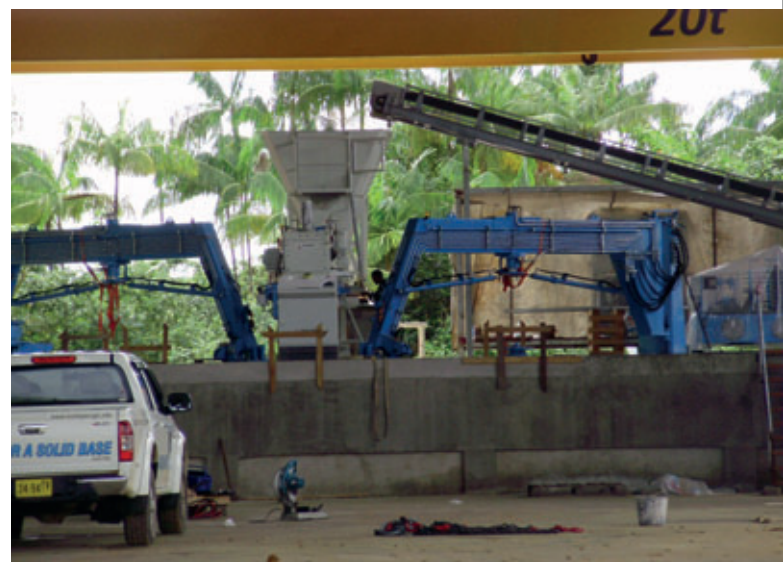
Montaje de la nueva instalación de producción
