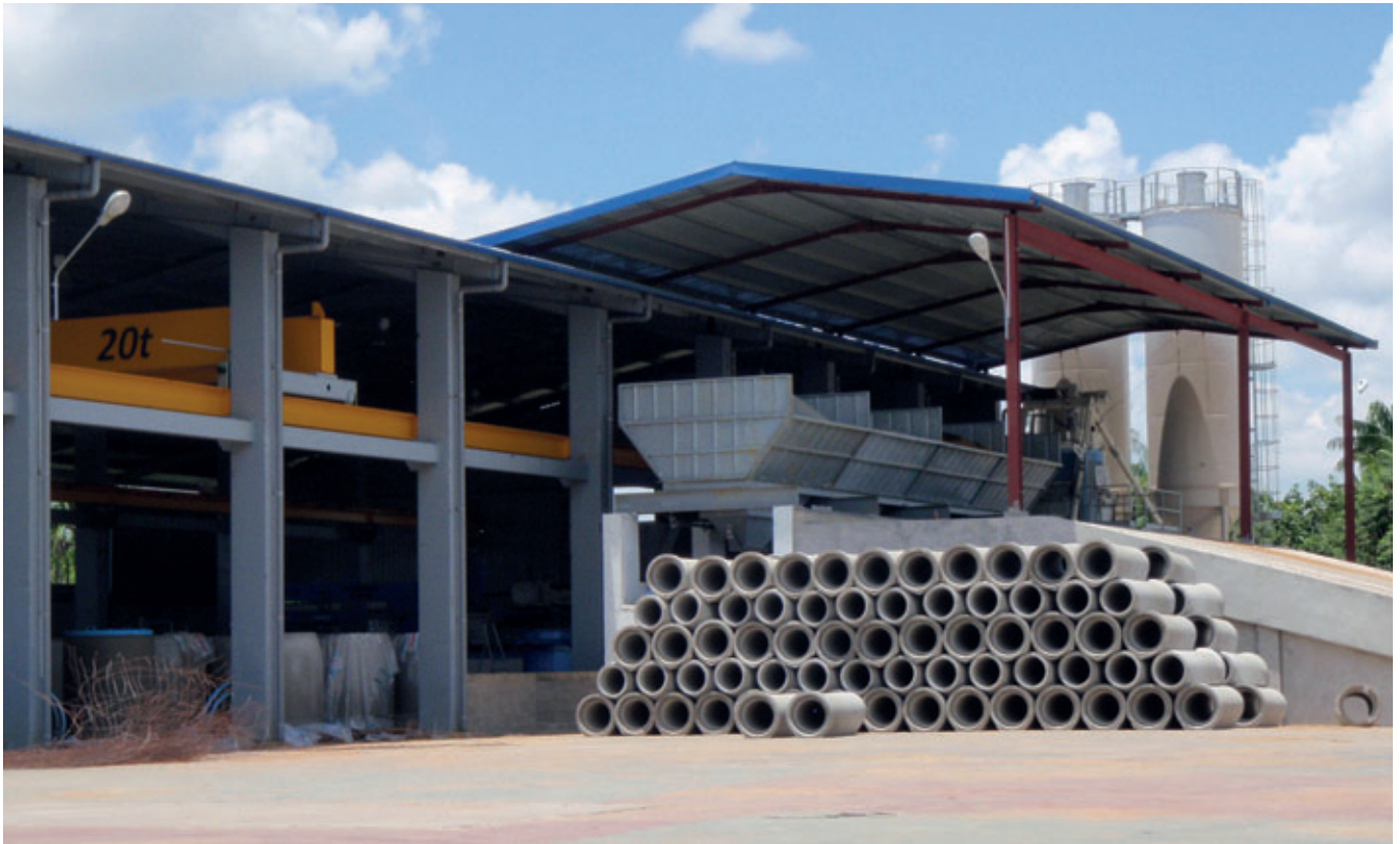
Vista exterior de la nueva instalación de fabricación de tubos
