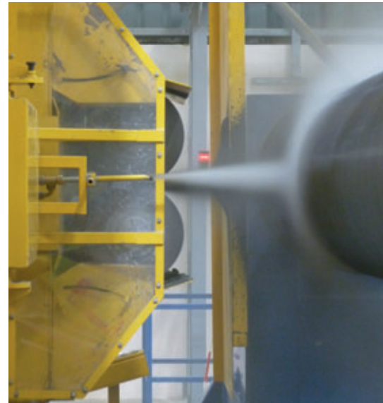
Im abschließenden Fertigungsschritt wird am Rohr mit Schleuderbeton eine äußere Schutzschicht angebracht.
