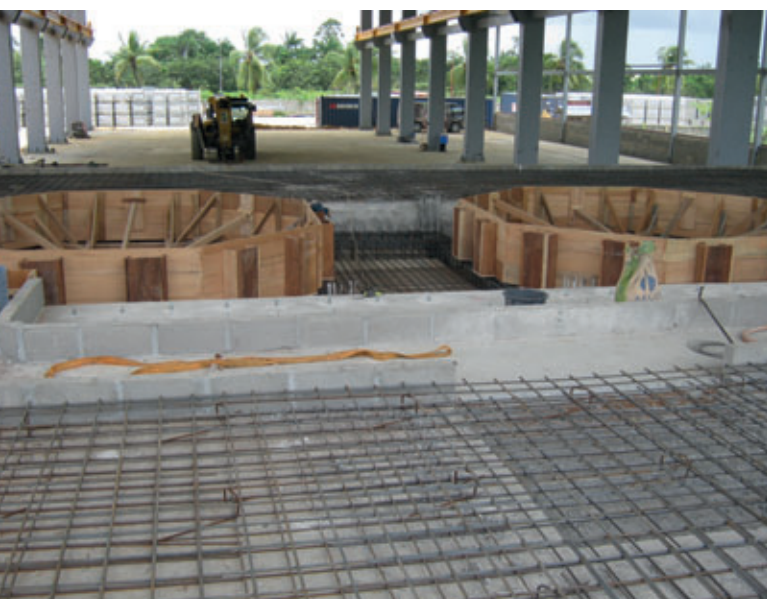
Vorbereitung der Fundamente
