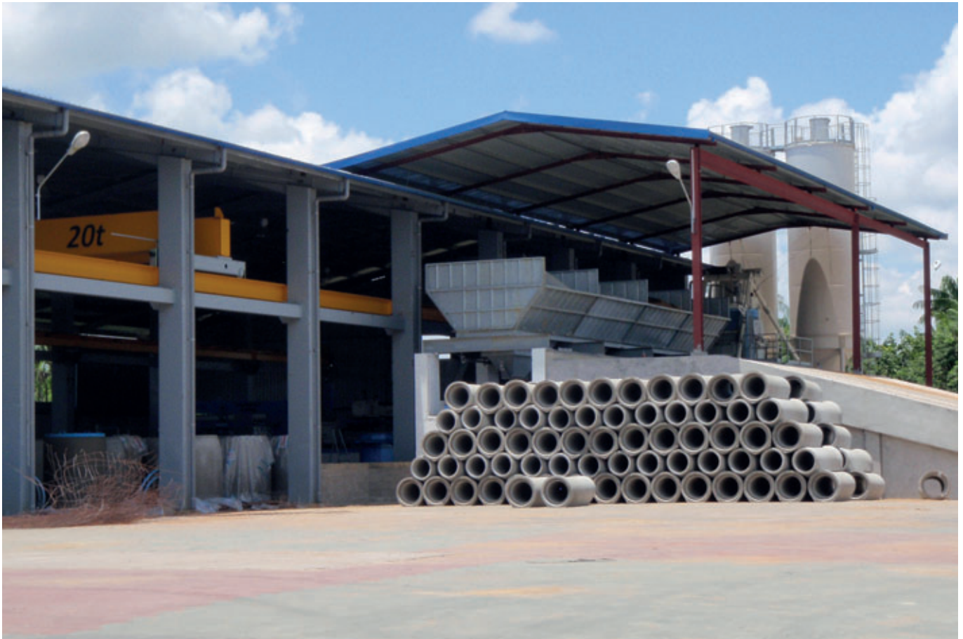
Außenansicht der neuen Rohrfertigungsanlage
